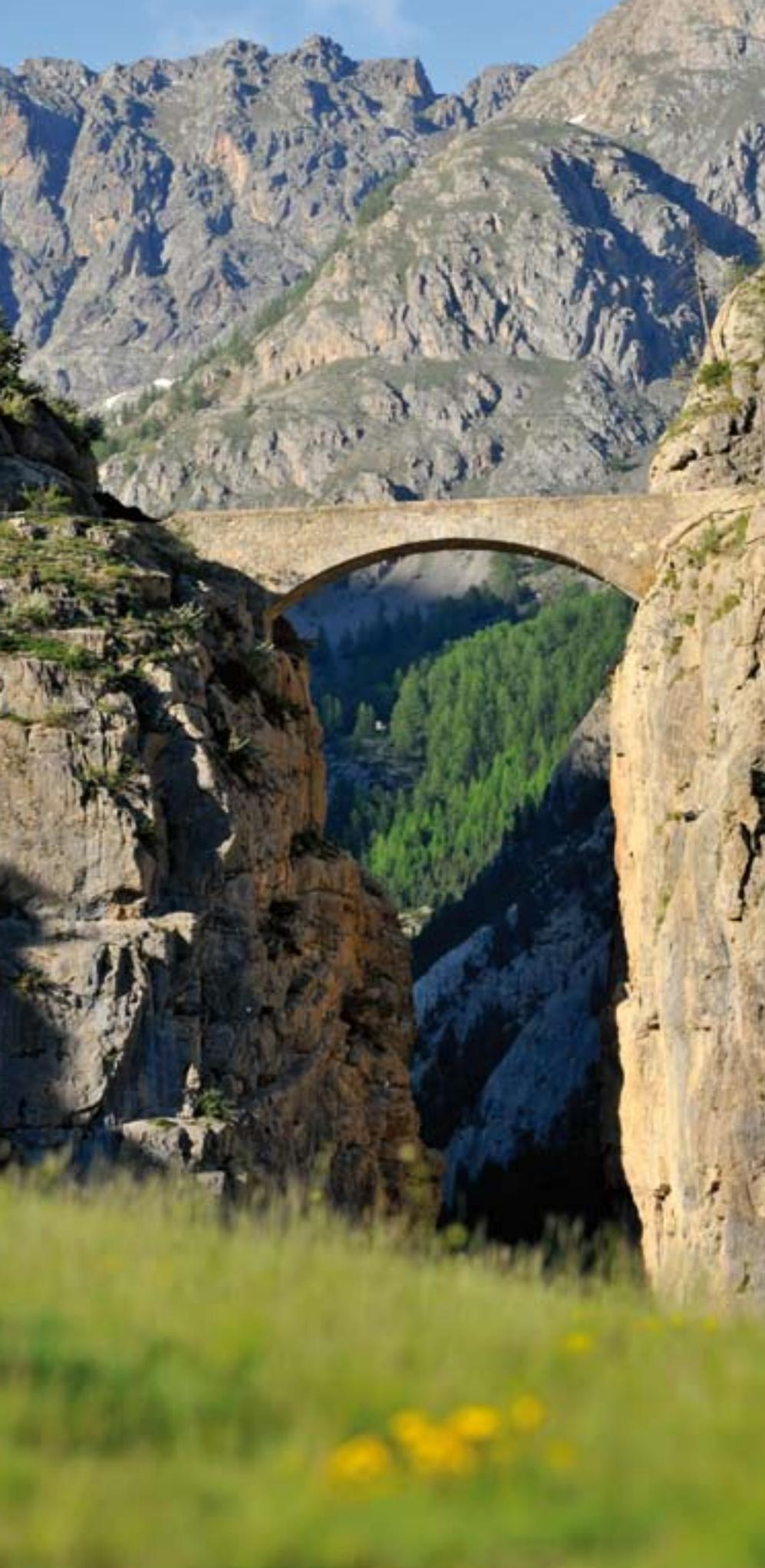
◀ Pour être reliés à la civilisation, les hommes n'ont reculé devant rien, enchaînant les prouesses techniques : bel exemple de cette obstination, le pont du Châtelet, ouvrage à arche unique construit entre 1880 et 1882 qui permet d'accéder à Fouillouse. Cette virgule majuscule posée au-dessus d'un gouffre de 108 mètres coiffe le verrou rocheux entaillé par l'Ubaye, une merveille !
